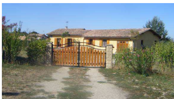
Maison pavillonnaire clôturée par une haie doublée de grilles et entourée des quatre côtés par le jardin
